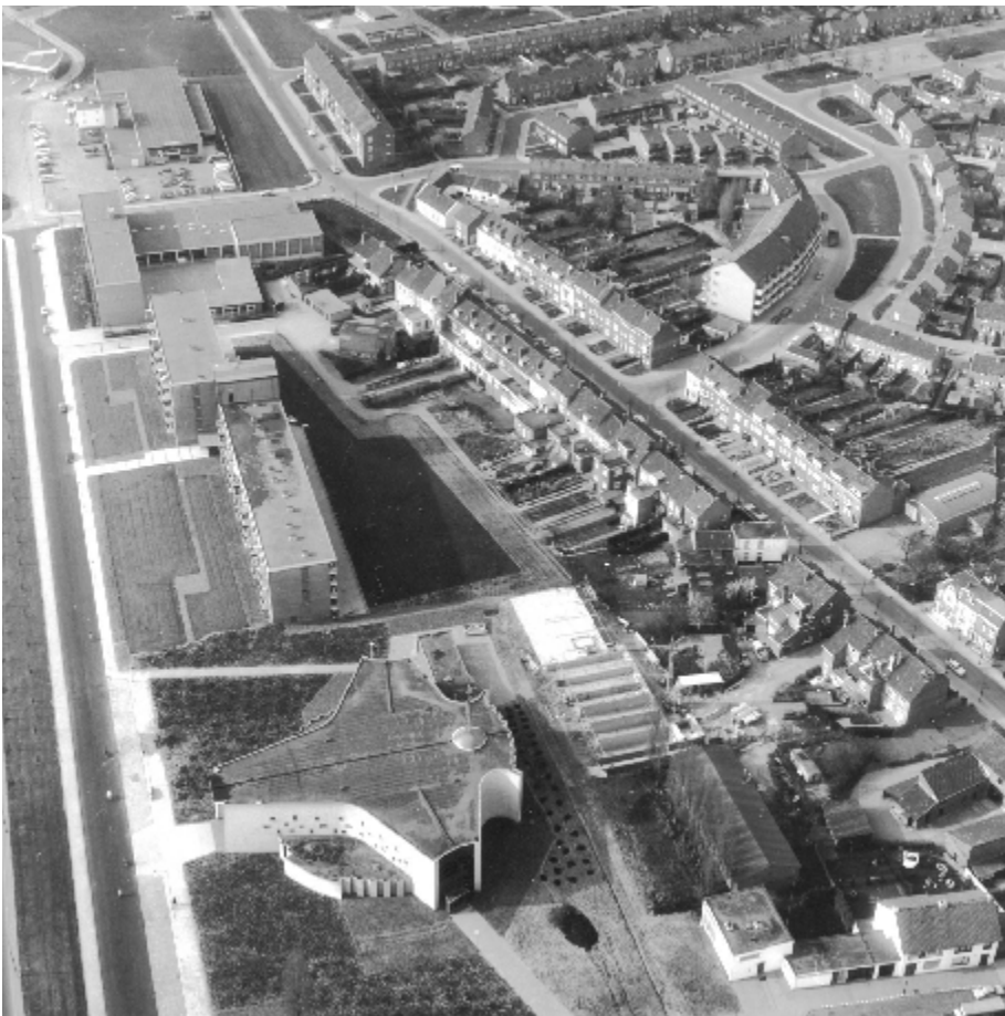
Op deze foto is duidelijk de kruisvorm van de Sint Annakerk en de stalen dakruiter te herkennen
